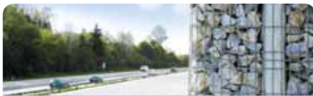
Razvrstitev po EN 1793: absorpcija A2 ali A3, izolacija B3
