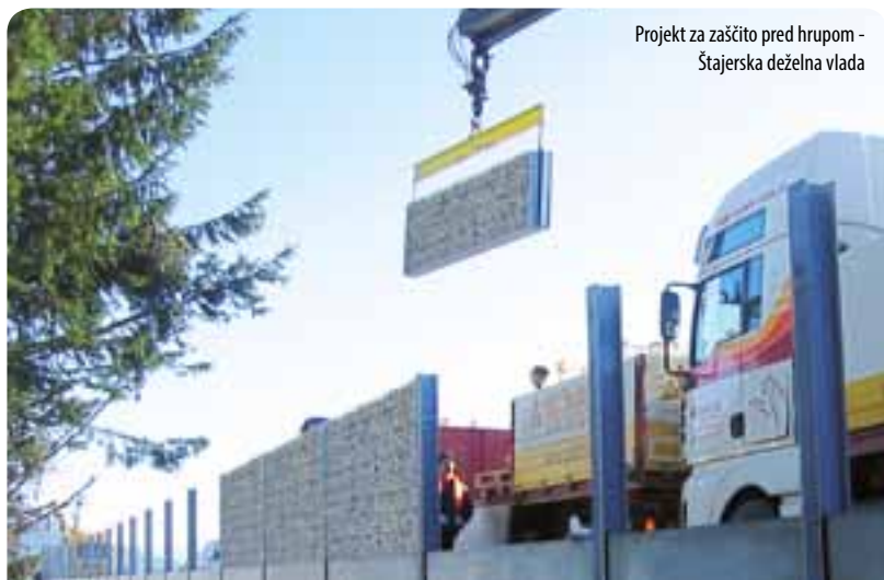
Razvrstitev po EN 1793: absorpcija A3, izolacija B3
